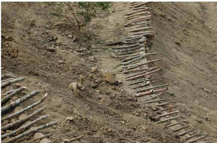
Figura. Detalle del sistema de trinchos y del material vegetal vivo apto para el rebrote. Lugar: Membrillal. Jipijapa – Manabí – Ecuador.
