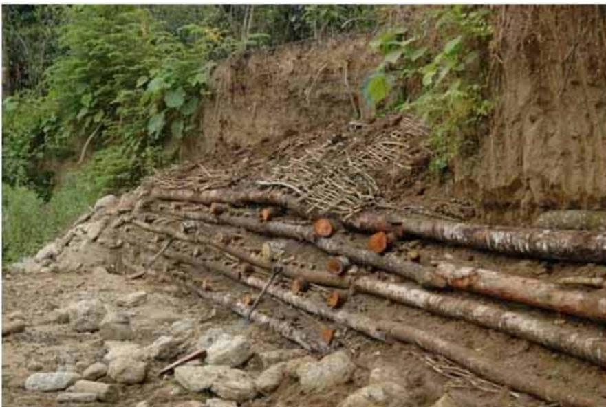
Figura. Sistema de trinchos en los que se ha utilizado, varillas de construcción y amarres metálicos, para proteger el talud en épocas en que el río se sale de su cause y se constituye en una amenaza para la escuela del lugar y para los residentes del sector.
