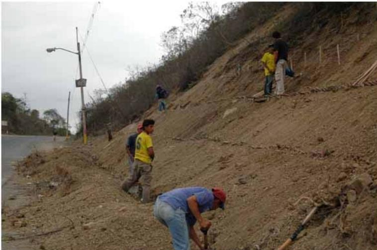
Figura. Obra para el controlar la erosión severa de un talud ubicado frente al vistoso monumento a la “Mazorca” de maíz. Este proceso erosivo además de constituirse en un peligro para carros y transeúntes, es anti-estético. Cuando crezcan las estacas y se recubra de vegetación el lugar, se obtendrá una la recuperación del paisaje, característica común de las obras de Ingeniería Naturalística.
