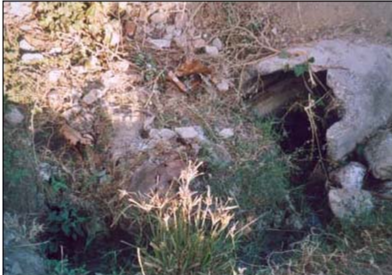
Figura 26 – Colector final existente
