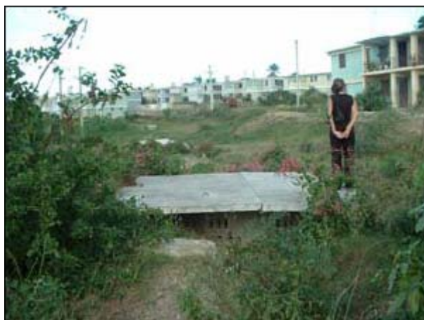
Figura 34 – Barrio Militar: tanque existente
