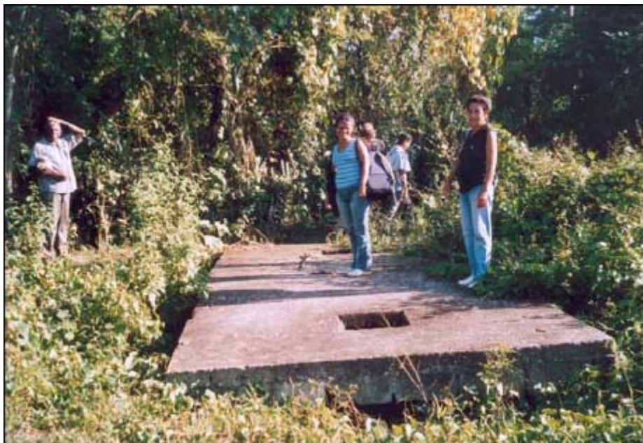
Figura 21 – Tratamiento primario existente
