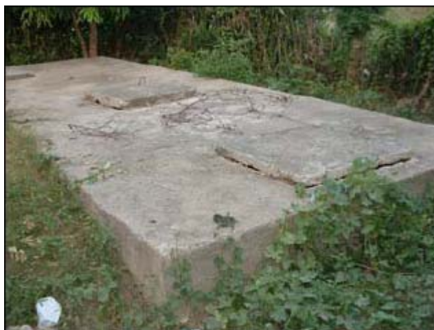
Figura 30 – Isleta: tanque existente
