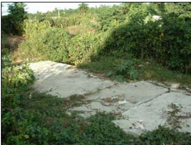
Figura 32 – Primero de Mayo 1: tanque existente
