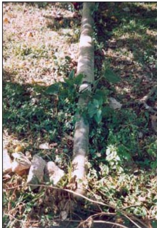
Figura 8 – Tubo particular que alimenta la fosa séptica
