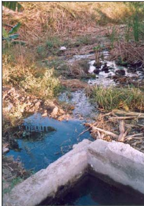
Figura 25 – Caja final que rebosa los residuales en la laguna
