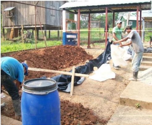
Un biofiltro es construido para tratar las aguas grises por la biofiltración, que elimina una cantidad significativa de contaminantes de las aguas grises antes de llegar al agua subterránea, río o humedal natural. La adición de patógenos, bacterias y toxinas no-biodegradables al agua de superficie puede ser evitada con este tratamiento biológico, promoviendo un ecosistema más sano. El sistema puede ser construido para una sola casa o un grupo de casas, con un costo bajo.
