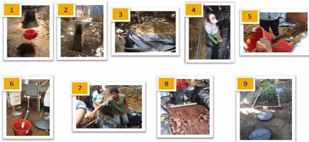
Figura. Pasos de construcción de un Biofiltro Domiciliar
