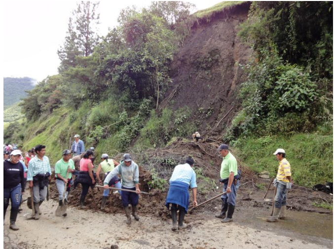
Trabajo en minga de la comunidad para la limpieza de la vía en el lugar seleccionado
