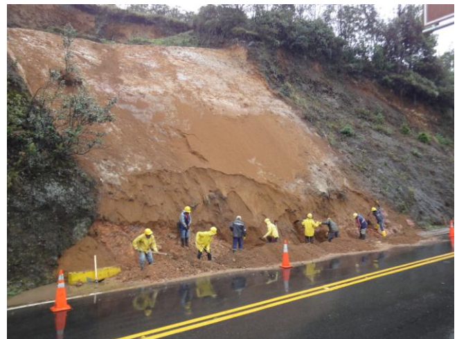
La excavación manual de la cimentación de la obra de sostén al pie del talud
