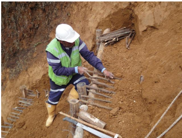
La colocación de las estacas vivas autóctonas, el "corazón" de la empalizada viva.
