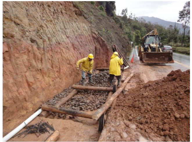
El primer nivel del entramado de madera, con tubo drenante en la parte trasera
