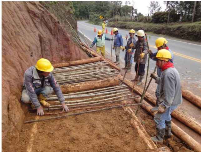
La colocación de las estacas vivas en el entramado de madera: el corazón de la obra
