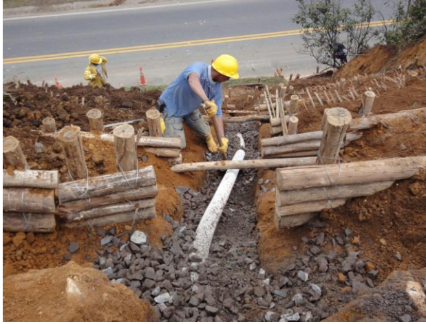
La realización del drenaje con tubo microfisurado y grava.
