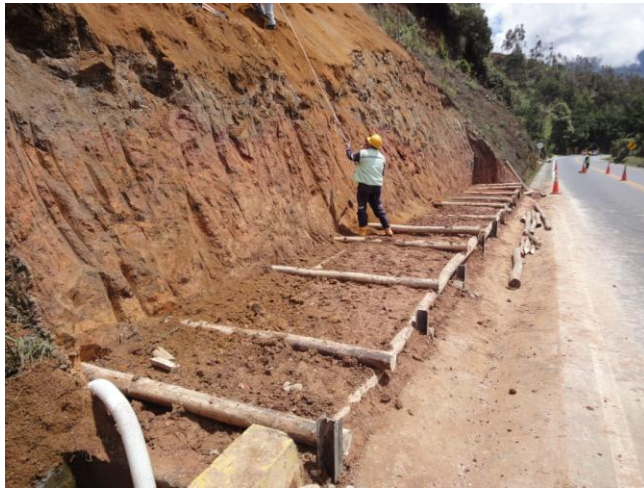
Los primeros niveles del entramado de madera completados
