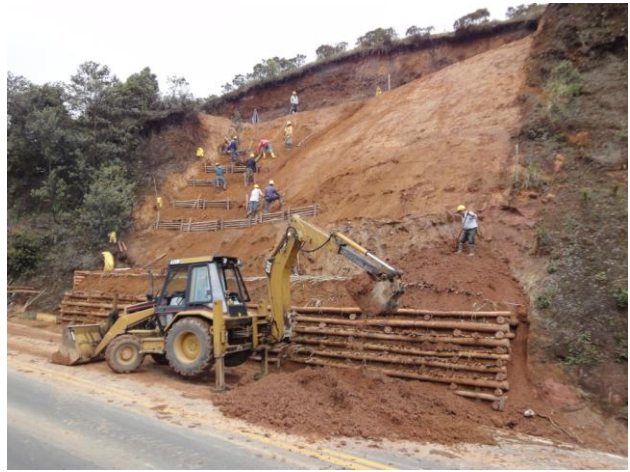
La reconfiguración del talud a la base y el comienzo de los trabajos en la parte de arriba.
