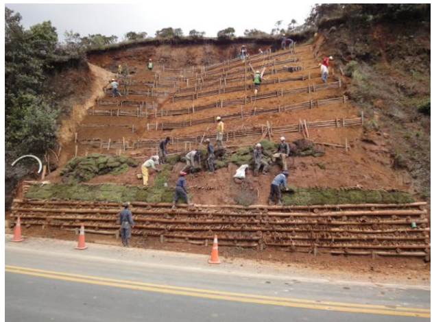
Recubrimiento del talud con césped para prevenir fenómenos erosivos.
