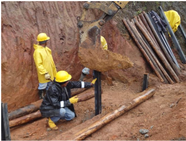
La cuchara de la maquina empuja el riel en la tierra para mayor estabilidad de la obra
