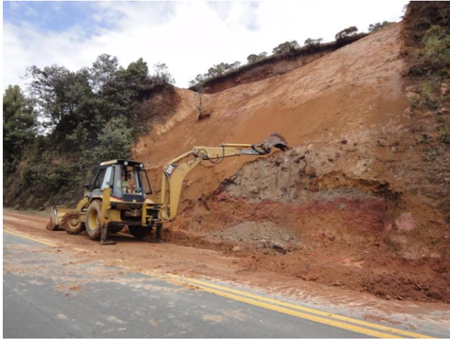
La maquina completa la excavación
