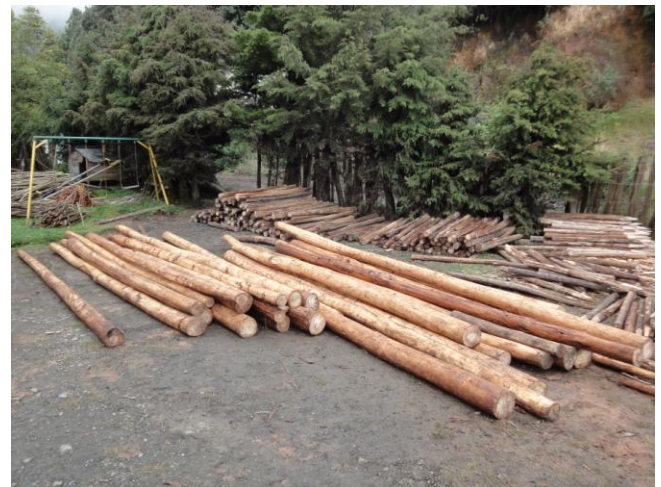
El área de depósito de los materiales a utilizar
