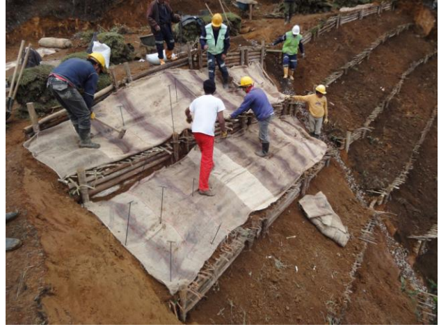
La colocación de red de cabuya procedente de sacos de café con finalidad antierosiva.
