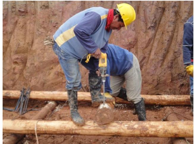
Perforación de los postes de madera para la sucesiva colocación de clavos
