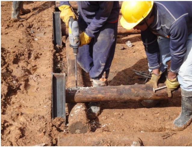
Detalle de la perforación de los postes de madera para la sucesiva colocación de clavos
