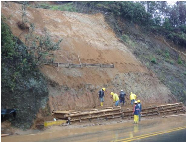
El entramado de madera a la base del talud en la fase intermedia del trabajo.
