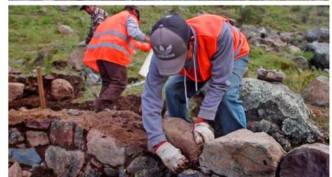
Las Amunas son un sistema ancestral de abastecimiento del recurso hídrico y de recarga artificial del acuífero. Son construidas con piedra impermeable y canales de infiltración permeables que permiten que el agua se filtre en el subsuelo durante la temporada de lluvias, de manera que las comunidades, a través de manantiales en la cuenca baja, la puedan cosechar en épocas de estiaje, cuando no hay lluvia.
