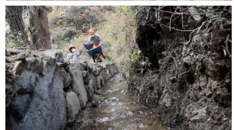
El Proyecto de Aquafondo consiste en la recuperación de las Amunas abandonadas o destruidas y en la instalación de estructuras complementarias, como instrumentos de medición y control para el seguimiento hidrológico. Para el trabajo en los canales amuneros, que aprovechan una infraestructura natural, se utiliza tierra, arena y piedra local, Aquafondo contrata directamente la mano de obra de la comunidad, brindando supervisión técnica con ingenieros y asistentes de ingeniería.
