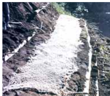
La colocación de una red en yuta para completar una intervención a lo largo de una orilla fluvial
