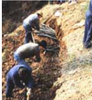
Una intervención estabilizante típica, los "lechos de ramaje"
